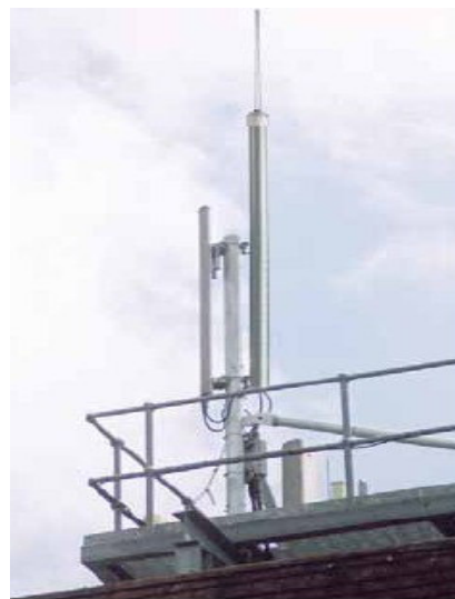
Ilustrácia inštalovaného ERITECH izolovaného zvodu
